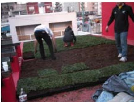
Para colocar este tipo de sistema no se necesitan conocimientos previos dado que es muy fácil manipularlo e instalarlo. Lleva leca o pometina en la parte inferior, malla geotextil como capa separadora entre el sustrato y el drenaje (no es antiraíz, como algunos consideran), la tierra adecuada a cada especie y la vegetación elegida.
